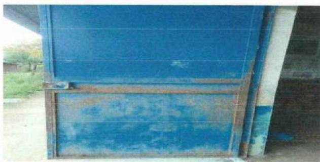
Foto 5: Mantenimientos de puertas de aulas.
