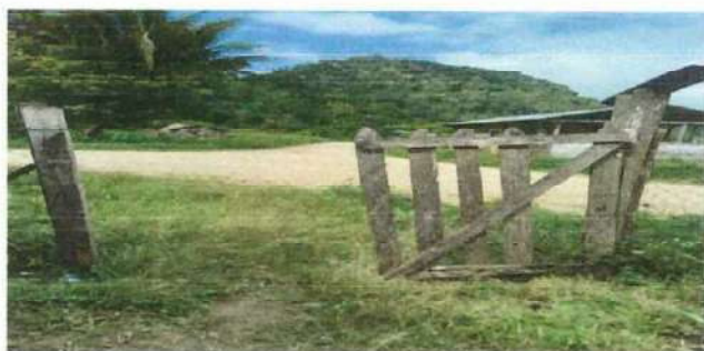
Foto 3: Sustitucion de portón de madera por metal.
