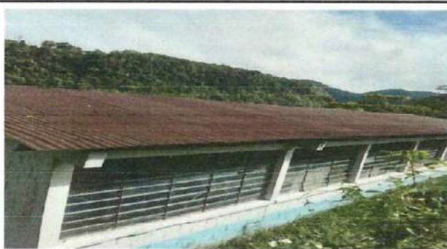
Foto1: Sustitucion de laminas por troqueladas
