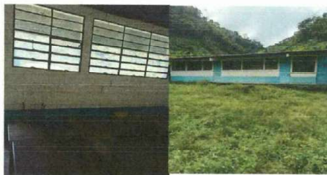
Foto 2: Pintura de interior y exterior.
